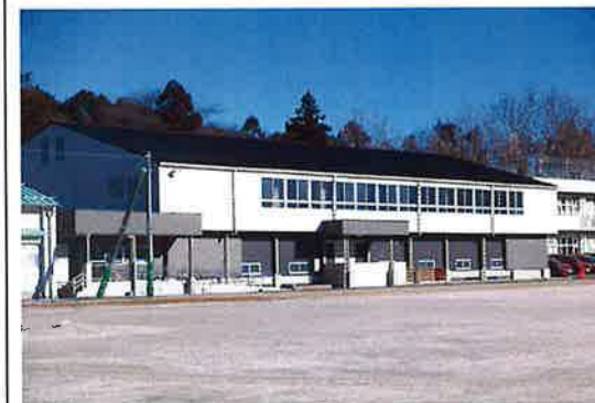
【太田建設】柏市立土中学校屋内運動場長寿命化改良工事(建築工事)
