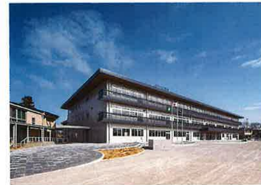
【広島・小倉・荒木特定建設工事共同企業体】柏市立田中小学校第一校舎建替工事(建築工事)
