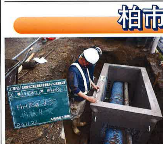
【入吉吉田工業】北柏駅北口地区国道6号情報ボックス布設他工事
