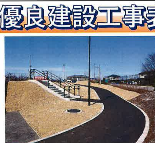
【常盤ガーデン】仮称・大室東御陵前街区公園整備工事(その2)
