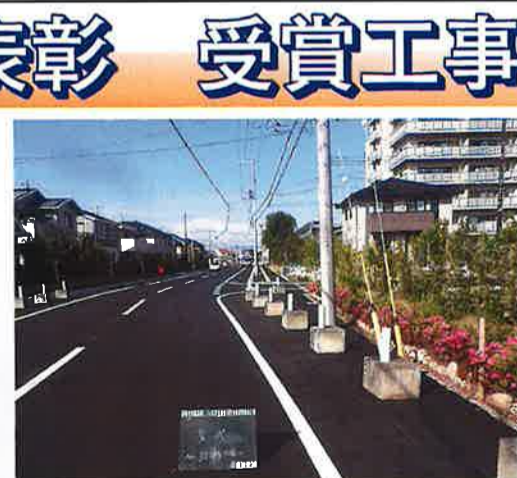
【日進建設】柏都市計画道路3・4・22号吉野沢高野台線道路改良工事
