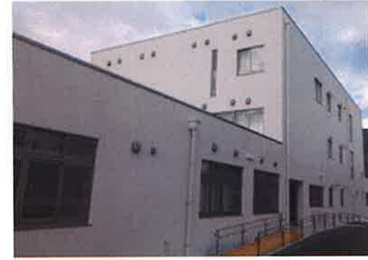
【城山電機】柏市立柏第三小学校校舎増築等工事(電気設備工事)
