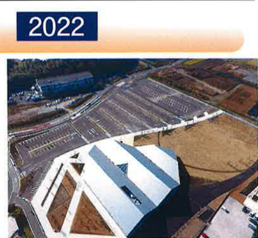
【日進・三和特定建設工事共同企業体】道の駅しょうなん再整備工事(土木工事)
